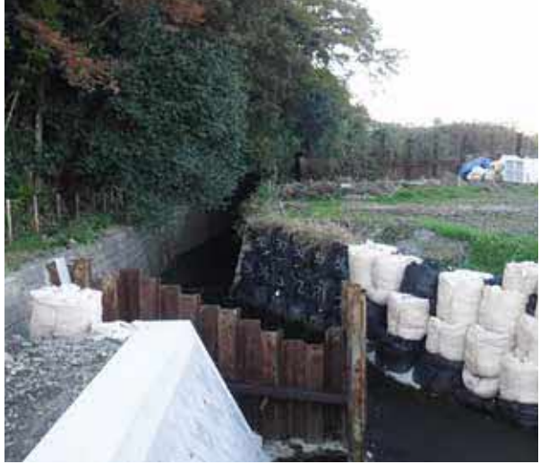
治水対策等で温暖化の災害に備える＝一色川護岸改修工事
